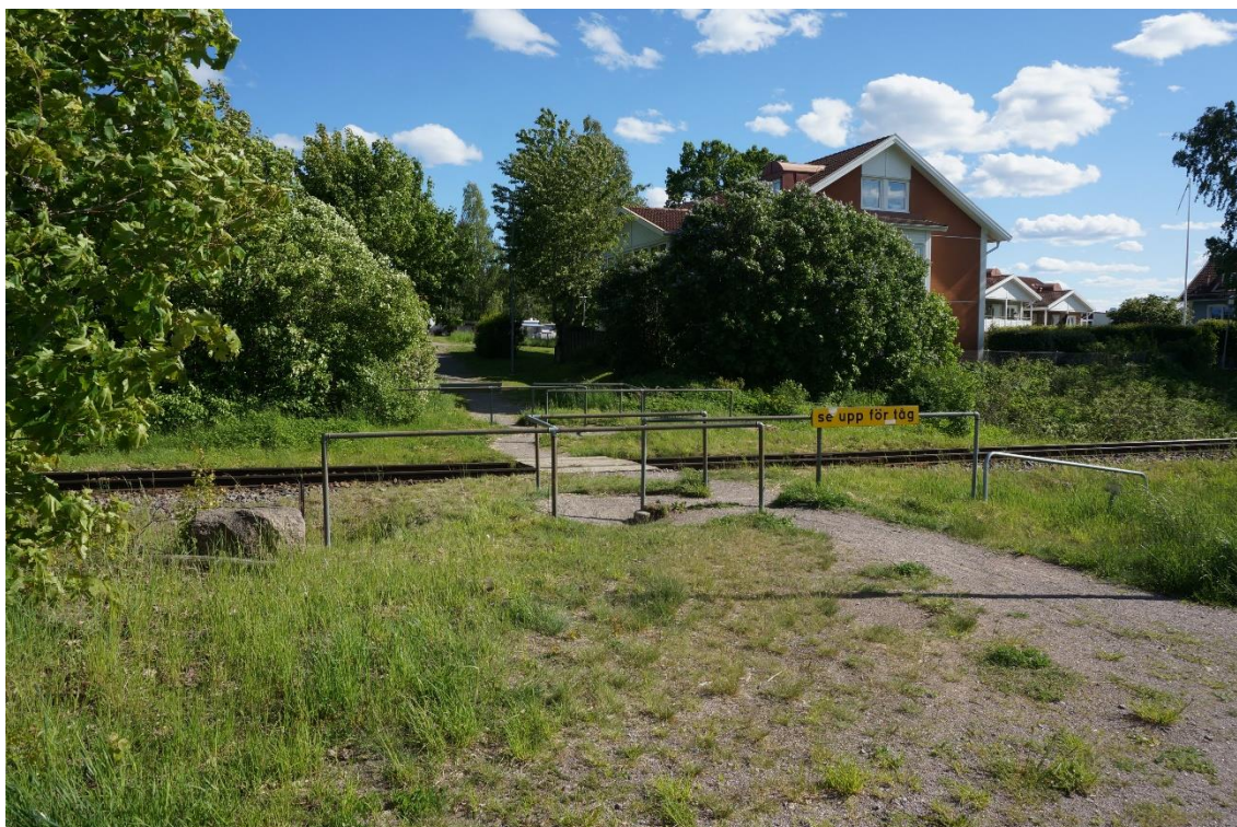
Figur 2: Obevakad gångpassage över järnvägen.
