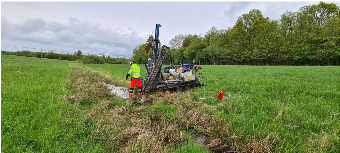
Bild från utförda undersökningar, Krågedal vecka 21 2021.
