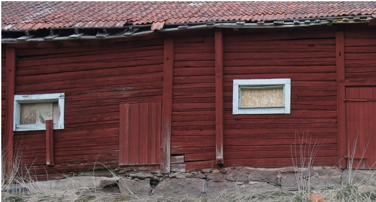
Foto 1. En gammal ladugårdsbyggnad ligger i direkt anslutning till detaljplaneområdet och bedöms kunna hysa fladdermuskolonier.
