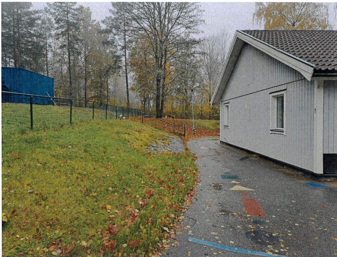
Berg i dagen söder om befintlig skolbyggnad.
