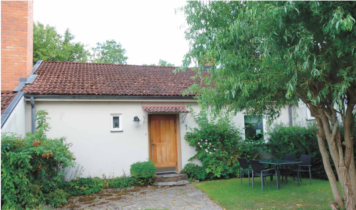
De tidigare lärarbostäderna med avskalade modernistiska fasader, låga byggnadskroppar, dörrar av ädelträ och ospröjsade fönster är viktiga karaktärsdrag hos byggnaderna (Fredriksson arkitektkontor 2021).
