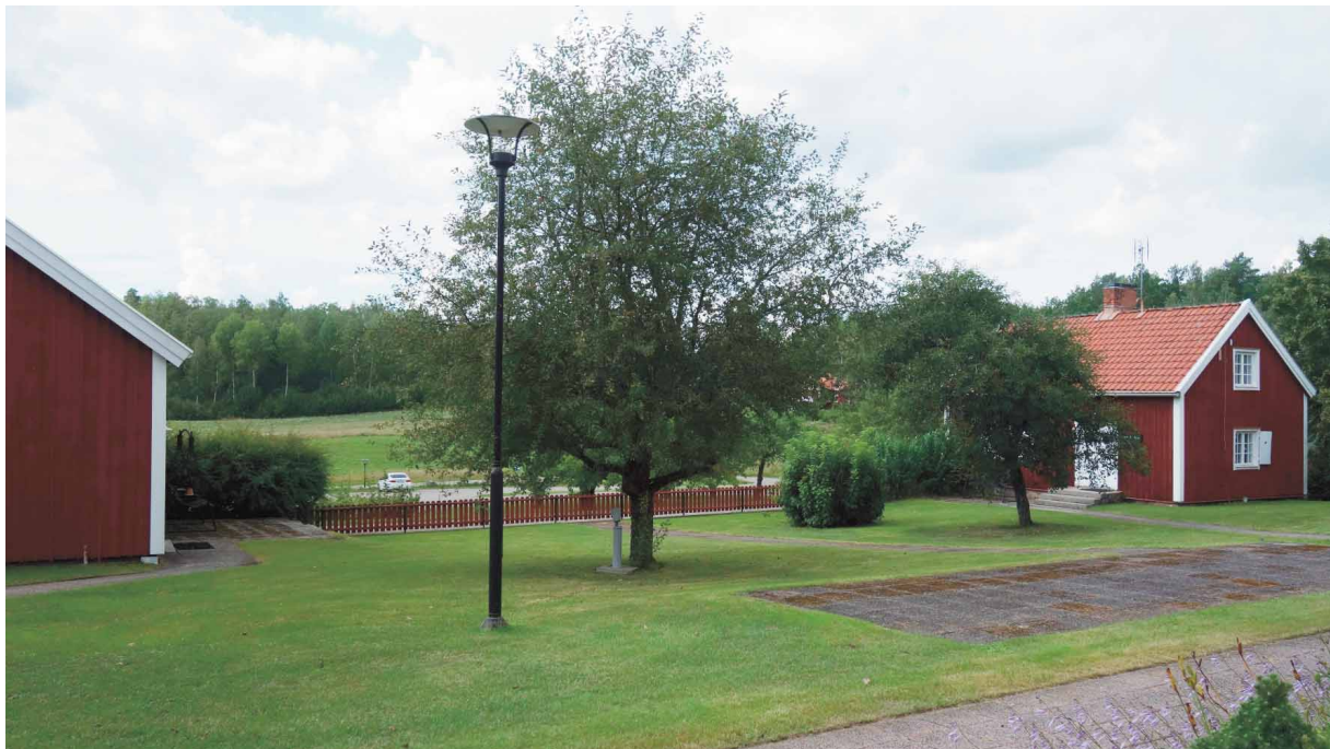
Storgårdens flyglar med ursprung i tidigt 1800-tal. I början av 1900-talet omvandlades till de till bostäder åt Fredrika Bremer förbundets lantbushällsskola efter ritningar av Sven Torgeruud i nationalromantisk stil. Husen renoverades på 1960-talet efter ritningar av Brunskegs arkitektkontor och fick antagligen ny panel i samband med detta. (Fredriksson arkitektkontor 2021).
