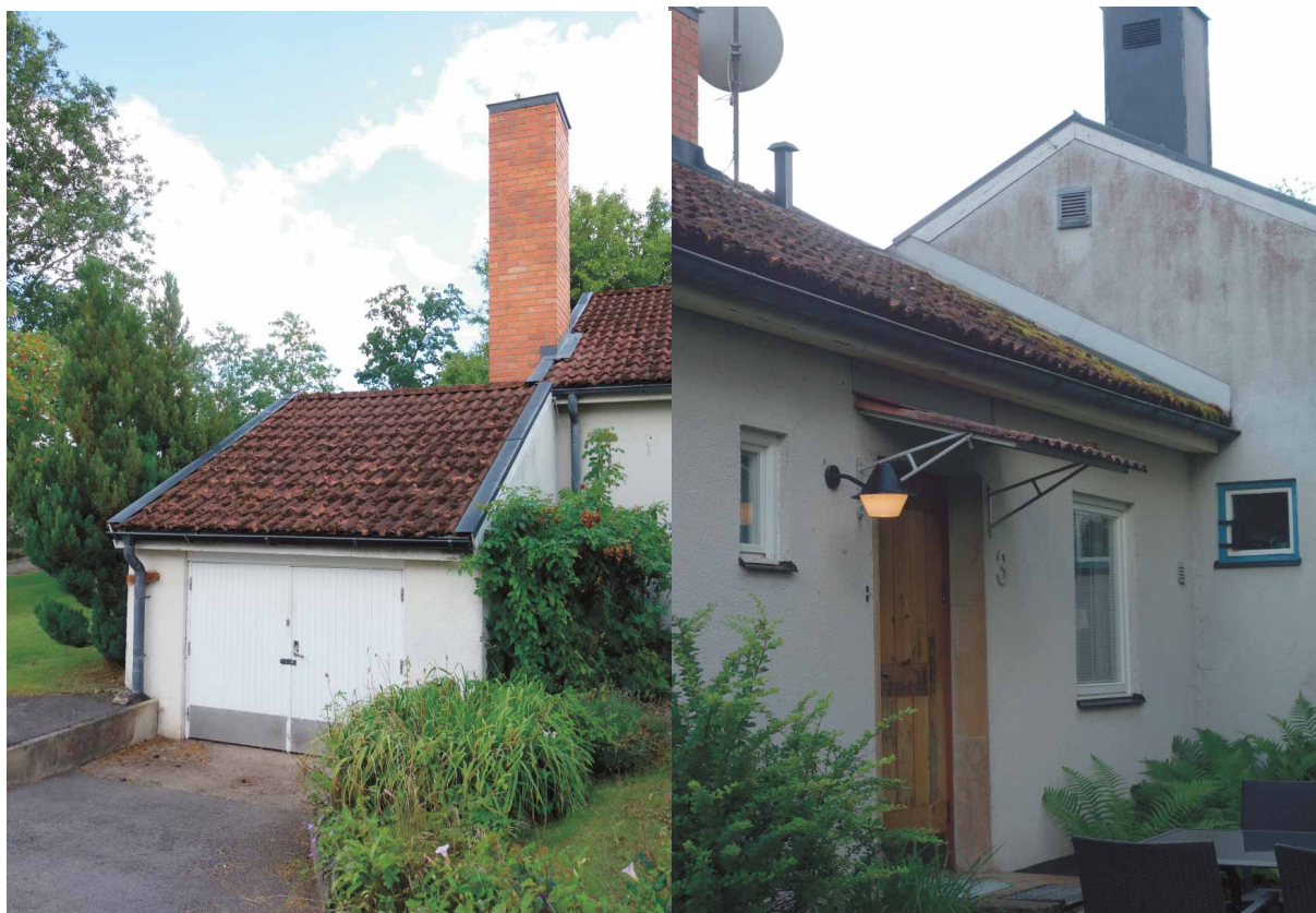
De tidigare lärarbostädernas välbevarade uttryck med nätta skärmtak, förskjutna byggnadsvolymer och ursprungliga lamparmaturer är viktiga karaktärsdrag hos byggnaderna (Fredriksson arkitektkontor 2021).
