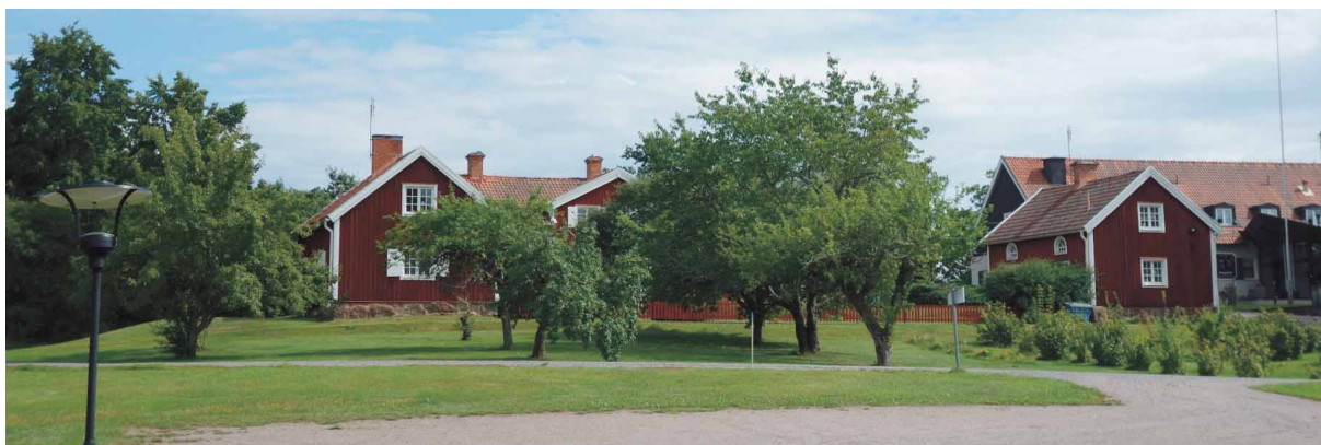
Storgårdsskolans gamla anläggning med byggnader från olika epoker på höjden ovan jordbrukslandskapet (Fredriksson arkitektkontor 2021).
