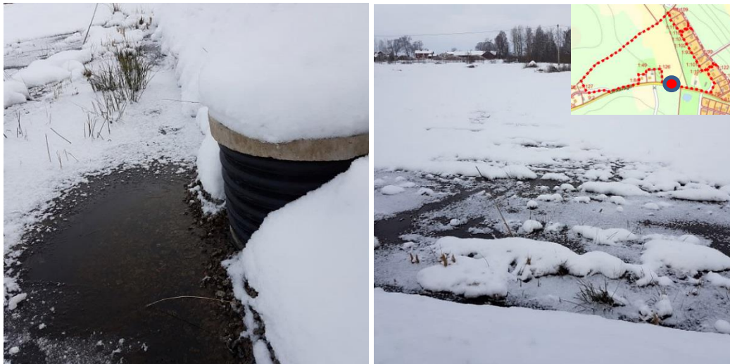
Figur 5. Utlopp vid Ulrikavägen på jordbruksmark. Foto: Tyréns AB.
