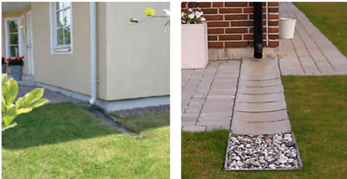
Figur 18. Exempelutseende av utkastare från takvatten ut på gräs. Källa: NSVA.
